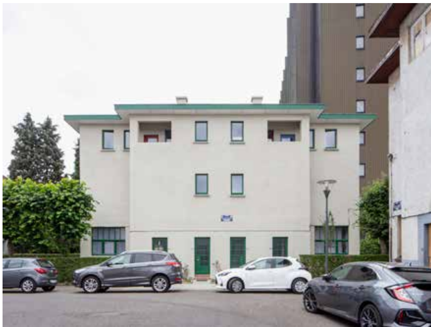
Tuinwijk "Moderne Wijk" in Sint-Agatha-Berchem, beschermd sinds 7 september 2000, restauratie en verbetering van de energieprestatie van nr. 39-41-43-45 Stichtingsstraat, foto 2023. Séverin Malaud © urban.brussels
