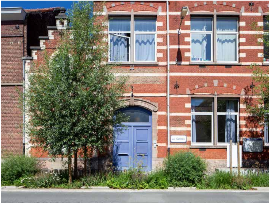
DWC "Abdij" in Anderlecht, waterloop, Driesstraat in Vorst, door Taktyk + INFRA Services + ecorce, foto 2022. Séverin Malaud © urban.brussels
